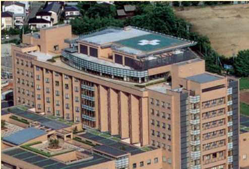
屋上ヘリポート
