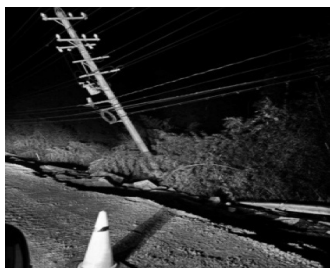
崖崩れの横を通過する所
